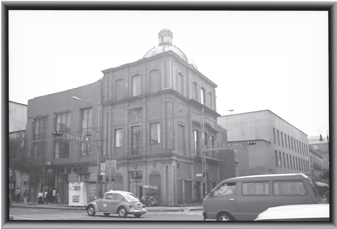
Ilustración 3. En este edificio de las calles de San Juan de Letrán de la capital mexicana se ubicó provisionalmente la primera escuela para sordomudos en México. Hoy es una biblioteca.
